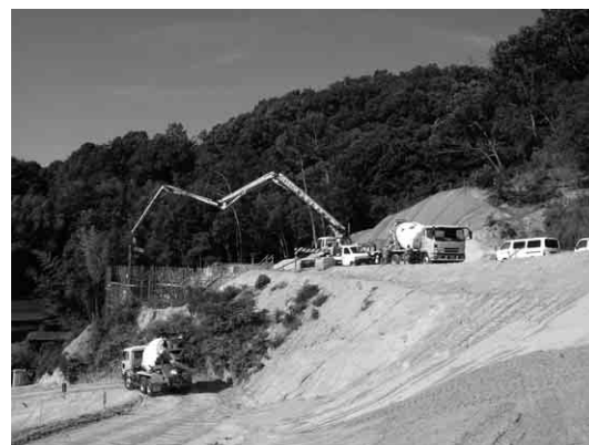
写真3 高炉スラグ微粉末を混和材に用いたコンクリート施工例
