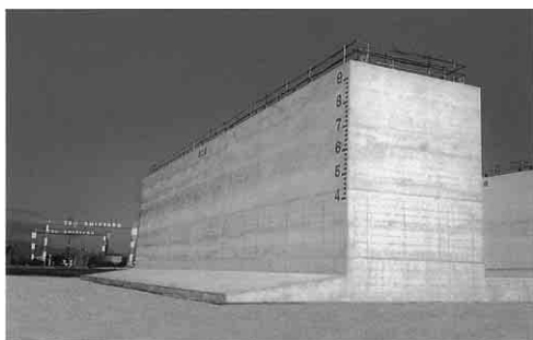
写真2 高炉セメントを用いて製造したケーソン
